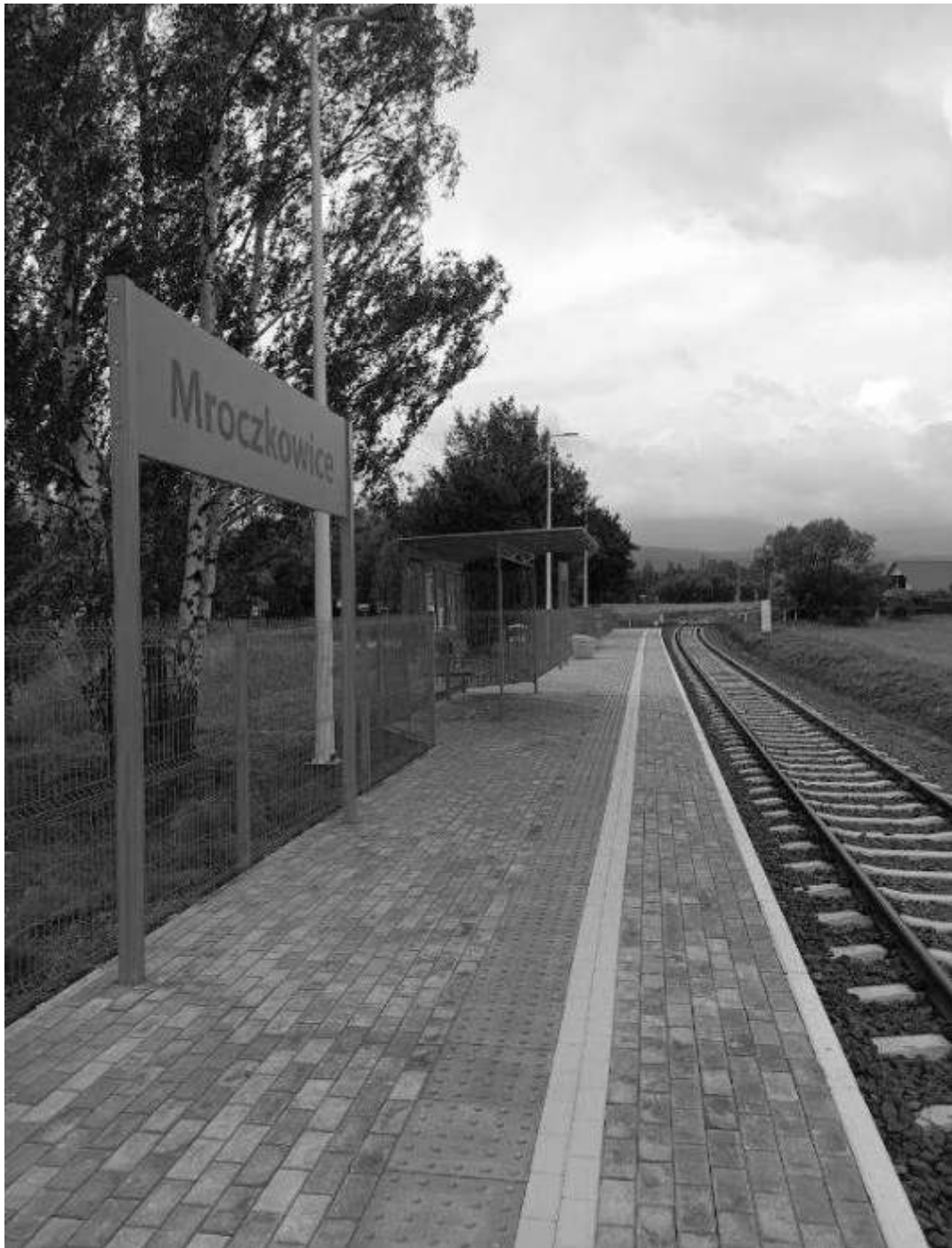
Figura 3-30 - Stația Mroczkowice (Sursa: Google Earth)
